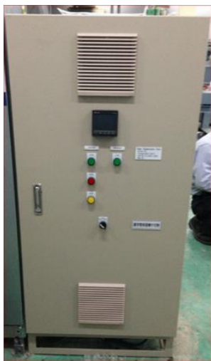
电梯增加节能控制装置
