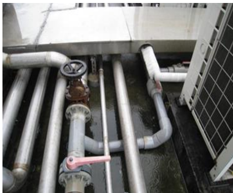
↑ 各厂雨水回收系统整合
