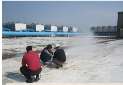
定期进行消防设备功能测试
